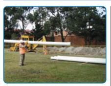
Las Tuberías PVC-O Amanco BIAXIAL® son más livianas, fáciles de transportar y manipular, así como de instalar, no requieren equipos pesados. Esto permite ahorro en costos y seguridad en los sistemas.
