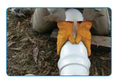
La Tubería PVC-O Amanco Biaxial<sup>®</sup> puede ser ensamblada en el borde de la zanja y luego instalada en el fondo como se muestra en las siguientes imágenes.
