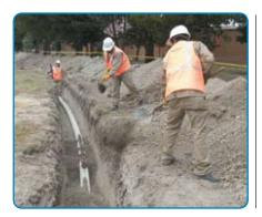
Los materiales adecuados para el encamado pueden ser triturado de roca (angular), Tamaño máximo de 3/4", canto rodado, tamaño máximo 1.1/2", arena lavada, arenilla o material proveniente de la excavación si es adecuado. Su selección dependera de la disponibilidad local y de la presencia o no de nivel freáico, caso en el cual debe usarse el primero.
