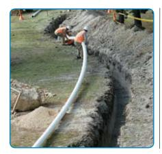
Capacidad de acomodarse sin afectación estructural de las tuberías a las condiciones del terreno.
